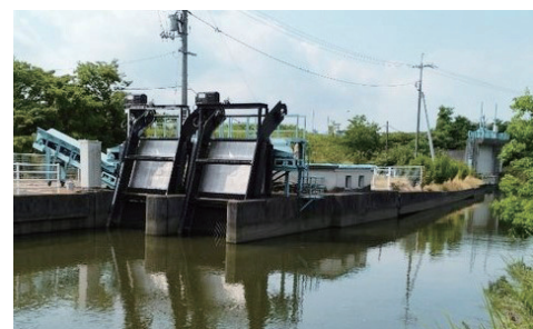
砂川に注ぐ方岡川排水機場を誘導できないか
