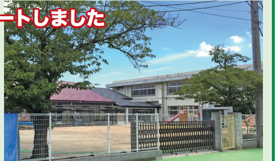
中山認定こども園。左が元保育園、右が元幼稚園間が新たに作られた廊下と職員室
