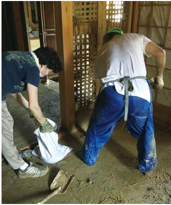
浸水した土壁を運び出します
