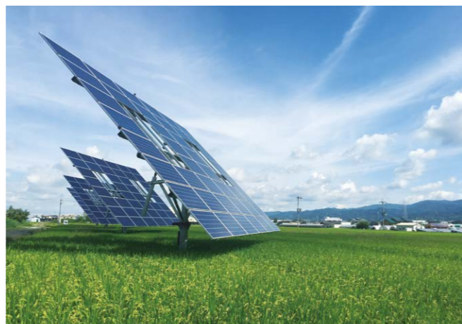
太陽センサーで向きを変えるソーラーパネル。台風の際はパネルが水平になるので、鳥取県では何度台風が来ても大丈夫だったそうです。Photo: エグテック社(天理市)提供
